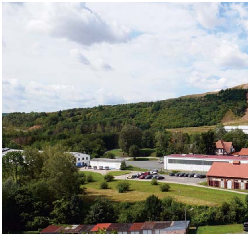
Ehemaliger Kali-Standort Sollstedt
