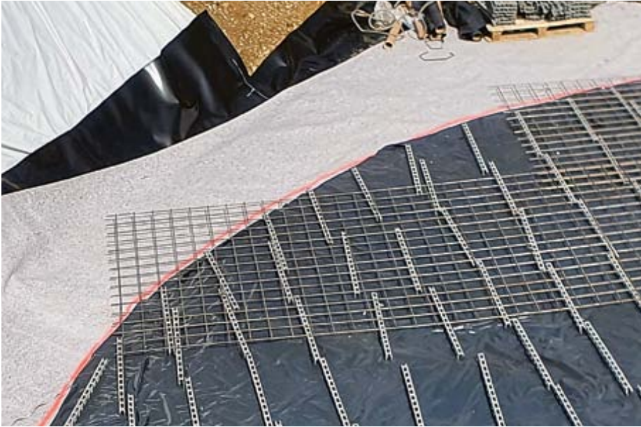
Der Einbau der Folien und Dränschichten ist für den Bauherrn und die Behörden wichtig.
