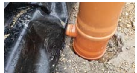
Überwachung kritischer Details beim Bau der Anlagen, hier Kontrollvorrichtung LES
