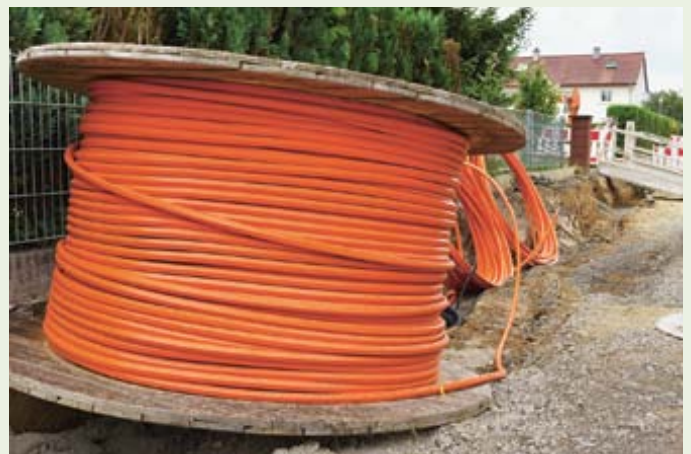
Der Glasfasernetzausbau in der Fläche ist aufwendig.
