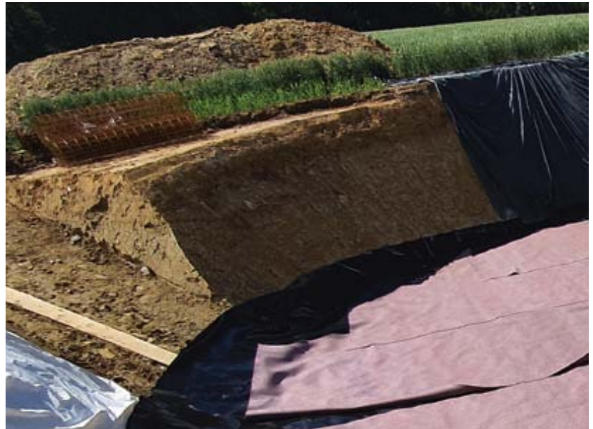
Bildliche Dokumentation und Überwachung für den Bauherrn zum Einbau von Behältern im Boden
